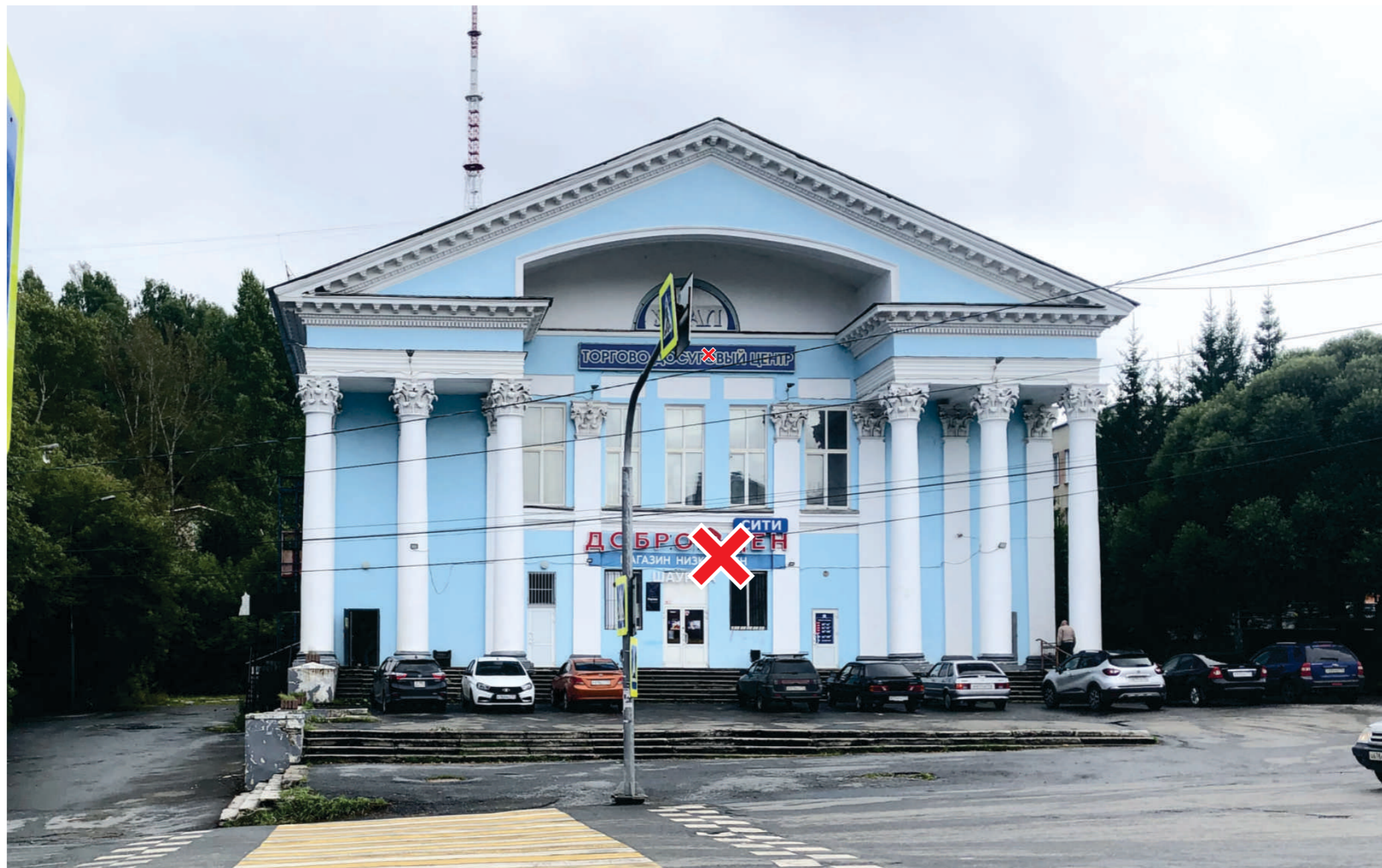
Ул. Ленина 9 Текущее состояние
